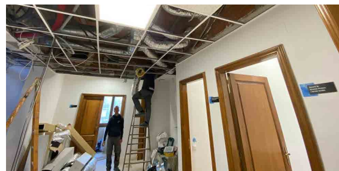
Obres de renovació de la ventilació i aportació d'aire exterior a les oficines de la Seu Social.
