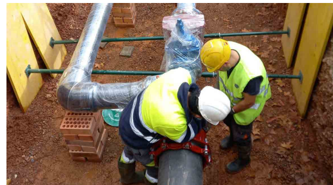
Obres d'instal·lació de la nova reguladora de pressió al barri de Gràcia.
